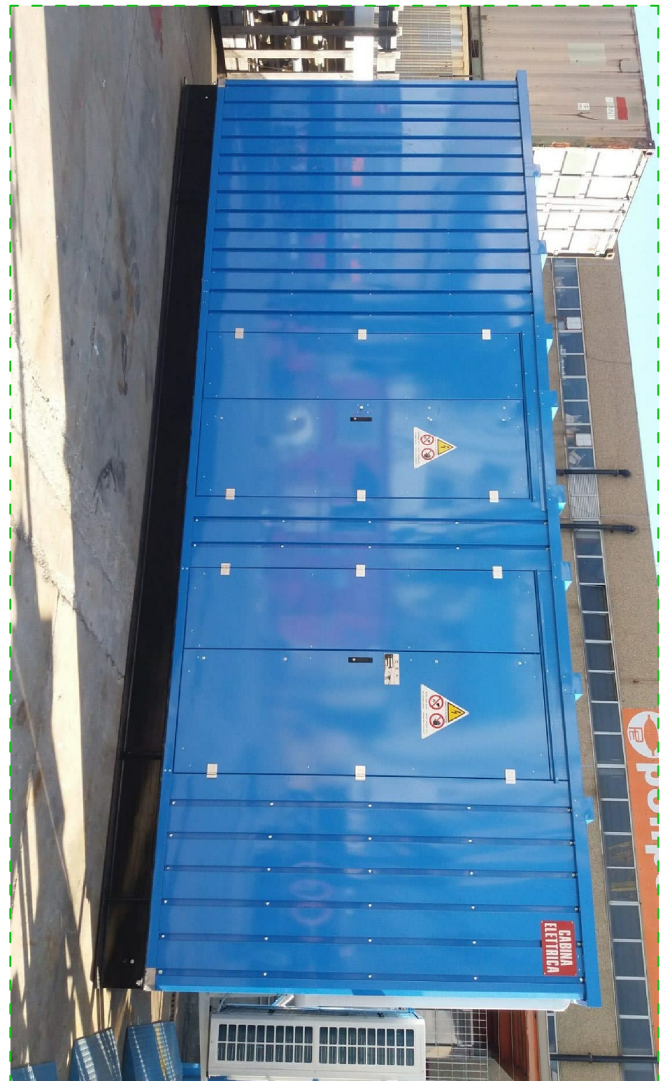
CABINA DI MEDIA TENSIONE PER ALLACCIAMENTO ALLA RETE ELETTRICA DI DISTRIBUZIONE
