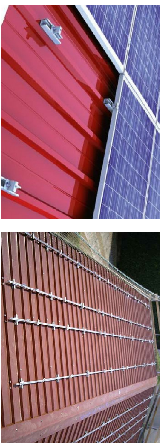
TIPOLOGIA DI INSTALLAZIONE SU LAMIERA GECATA
